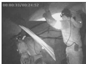
(b) 后续工人准备材料打密闭
