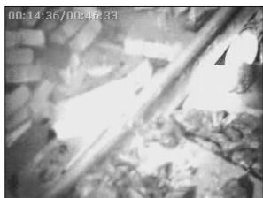
(d) 爆炸冲垮的密闭墙
