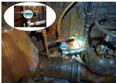
图 8 传感器水压监测施工
