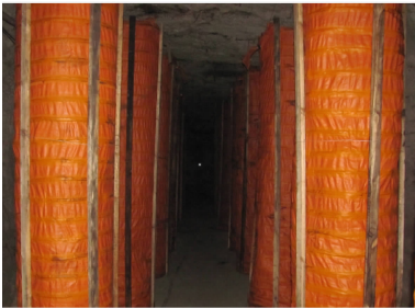
图 4 泵送支柱现场模型 Fig. 4 Pumping pillar field model
