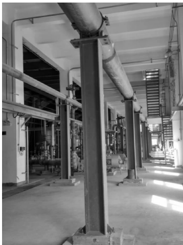
图 7 管道支架现场安装效果
