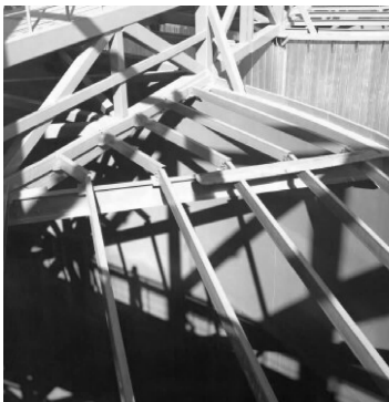
图 4 轻型储罐罐顶檩条布置现场安装效果(局部)
